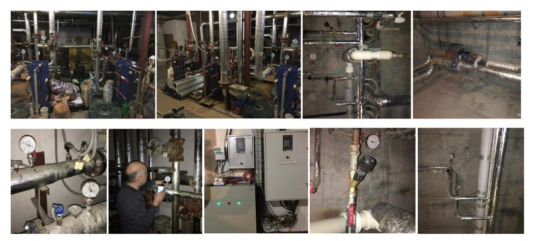
Распределение теплоносителя и воды по стоякам отопления и водоснабжения осуществляется в подвальных помещениях домов. Балансировка давления в трубопроводах системы отопления в домах №6 и №8 осуществляется с использованием регуляторов, в доме № 4 ручным способом путем частичного перекрытия потока теплоносителя.
